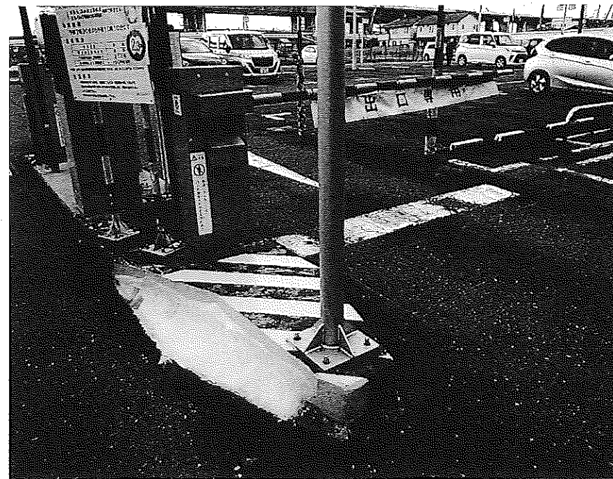
②南側駐車場（白部分が削いだ箇所）
